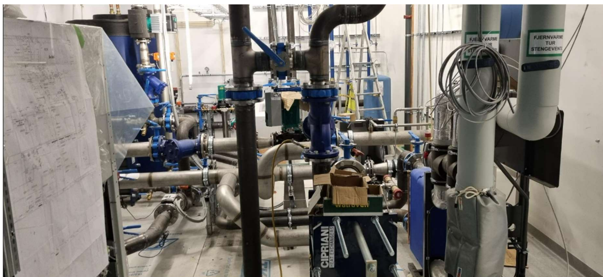
(eksempel på kaotisk teknisk rom med for lite plass)
